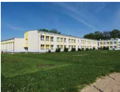
Obiekt Szkoły Podstawowej w Dębem Wielkim po wykonaniu prac termomodernizacyjnych
