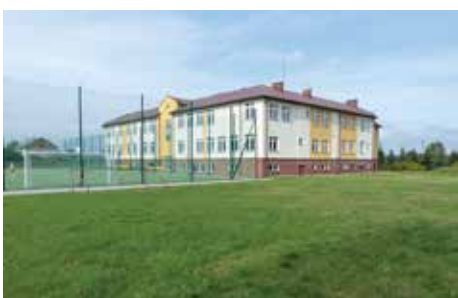
Obiekt Szkoły Podstawowej w Cygance po wykonaniu prac termomodernizacyjnych
