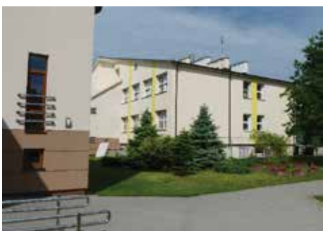
Obiekt Gimnazjum w Dębem Wielkim po wykonaniu prac termomodernizacyjnych
