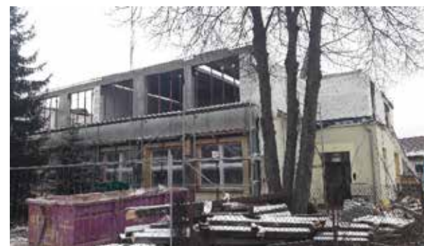
Roboty budowlane – Szkoła Podstawowa w Górkach
