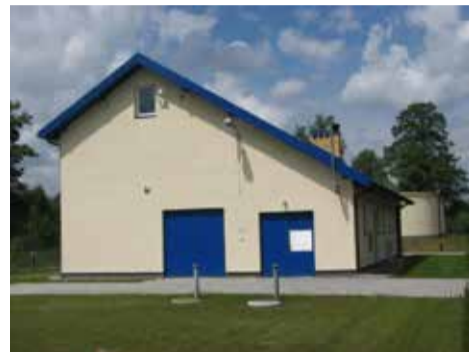
Stacja Uzdatniania Wody ul. Zdrojowa 12 Widok z zewnątrz i wewnątrz budynku
