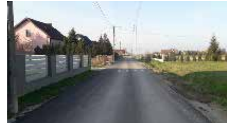
Nakładka asfaltowa - Aleksandrówka ul. Mazowiecka.
