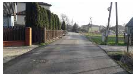
Nakładka asfaltowa - Chrośla, gmina Dębe Wielkie (odcinek ulicy Kwiatowej).
