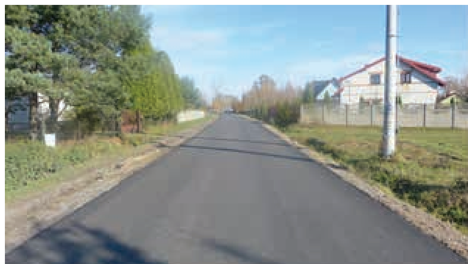
ul. Powstańców w Ostrów Kani po modernizacji
