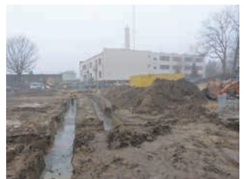
Budowa Przedszkola w Dąbrowie Wielkiej
