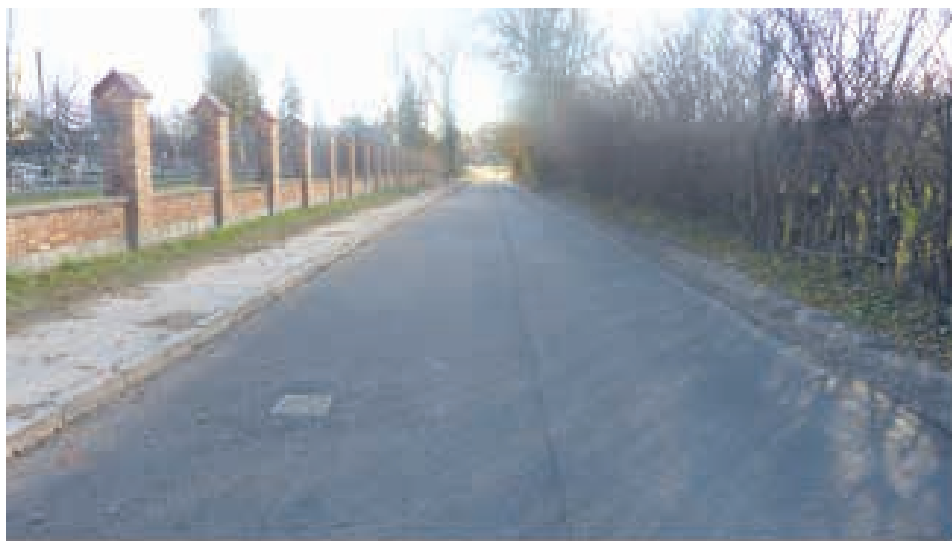
ul. 103 Batalionu Strzelców po modernizacji
