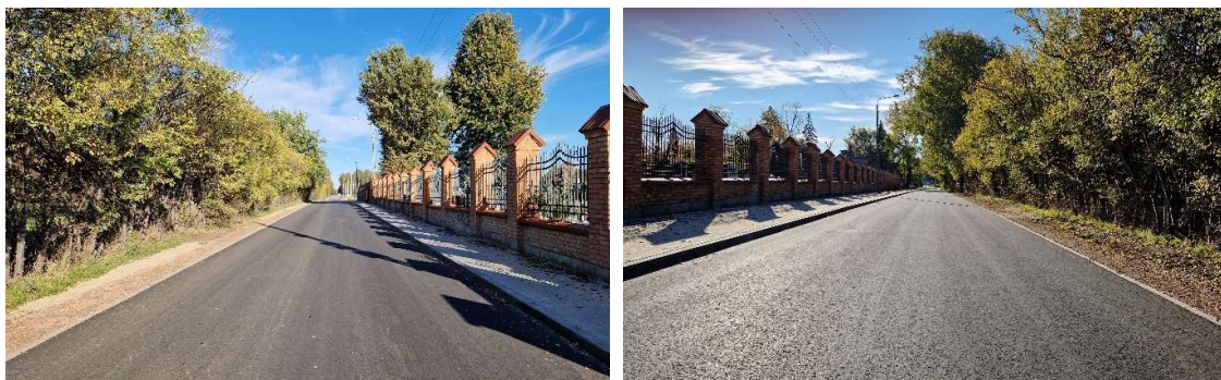
Fot. Wyremontowany odcinek ul. 103 Batalionu Strzelców w miejscowości Aleksandrówka
