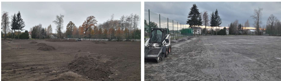
Fot. Budowa boiska sportowego w Celinowie.
