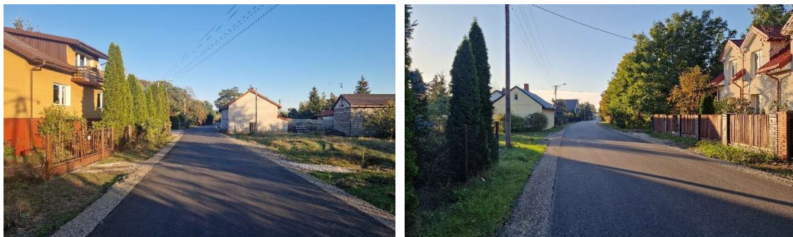
Fot. Przebudowany odcinek drogi w miejscowości Choszczówka Stojeczka
