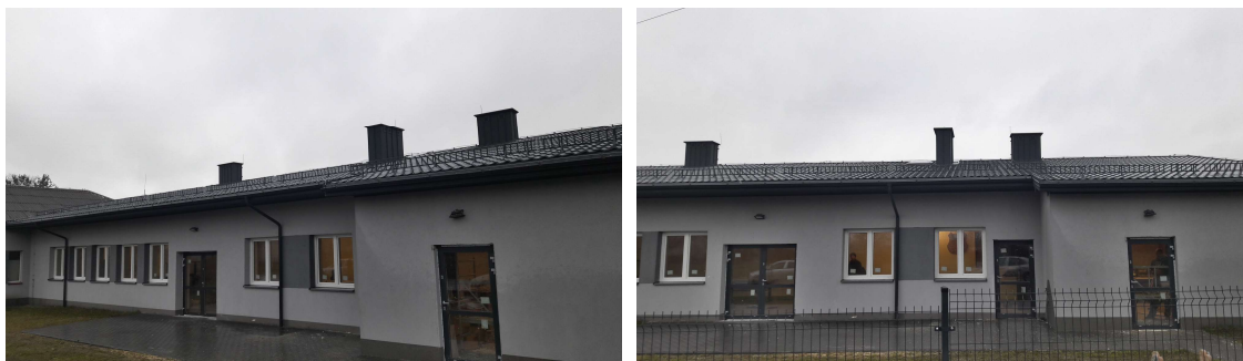
Fot. Zmodernizowana świetlica wiejska w miejscowości Jędrzejnik.
