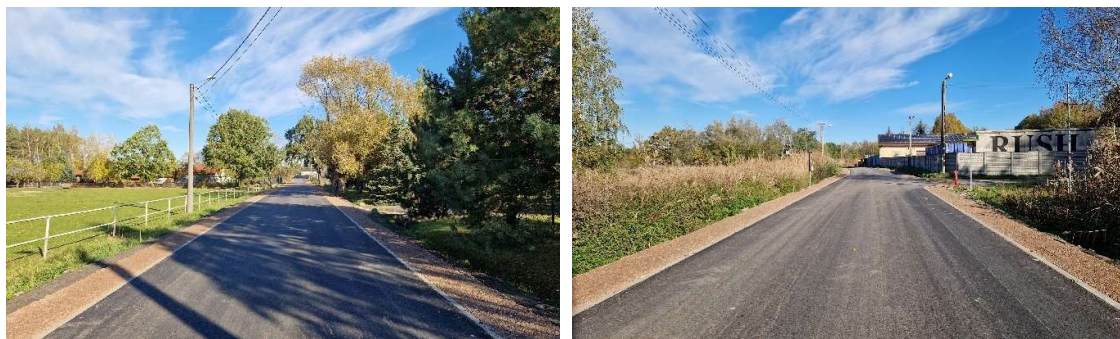
Fot. Przebudowany odcinek ul. Brukowej w miejscowości Olesin (odcinek na północ od autostrady A2)
