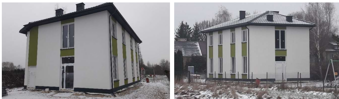
Fot. Budowany budynek świetlicy wiejskiej wraz z lokalami mieszkalnymi na I piętrze w miejscowości Aleksandrówka.
