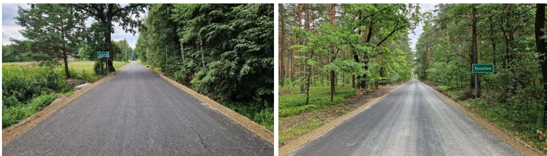
Fot. Przebudowana droga w miejscowości Teresław
