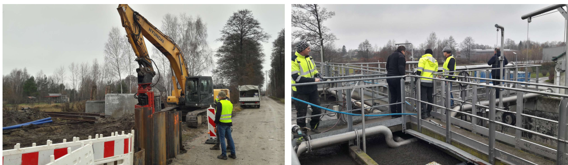
Fot. Prace przy budowie przepompowni ścieków oraz na oczyszczalni ścieków w miejscowości Dębe Wielkie
