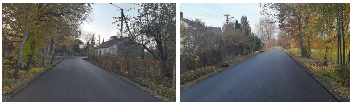
Fot. Zmodernizowany odcinek drogi w miejscowości Jędrzejnik
