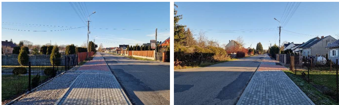
Fot. Wybudowany chodnik przy ul. Hr. M. Starzeńskiego w Rudzie
