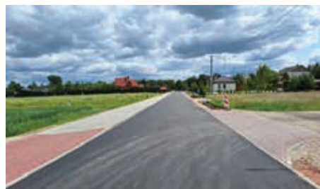
Fot. Budowa drogi gminnej ul. Szkolnej w miejscowości Cyganka gmina Dębe Wielkie
