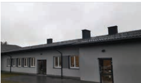
Fot. Zmodernizowana świetlica wiejska w miejscowości Jędrzejnik.
