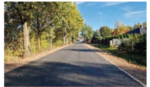
Fot. Przebudowany odcinek ul. Brukowej w miejscowości Olesin (odcinek na południe od autostrady A2)
