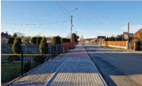
Fot. Wybudowany chodnik przy ul. Hr. M. Starzeńskiego w Rudzie
