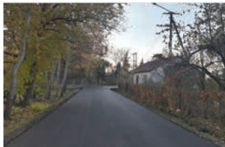
Fot. zmodernizowany odcinek drogi w miejscowości Jędrzejnik
