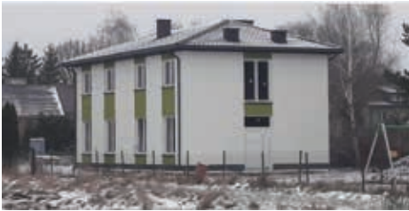
Fot. Budowany budynek świetlicy wiejskiej wraz z lokalami mieszkalnymi na I piętrze w miejscowości Aleksandrówka.
