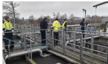
Fot. Prace przy budowie przepompowni ścieków oraz na oczyszczalni ścieków w miejscowości Dębe Wielkie
