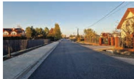
Fot. przebudowany odcinek ul. Armii Krajowej w Dębem Wielkim
