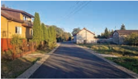
Fot. Przebudowany odcinek drogi w miejscowości Choszczówka Stojcka
