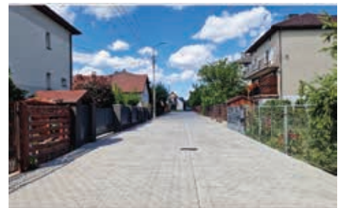
Fot. Przebudowana ul. Kosmiczna w miejscowości Dębe Wielkie
