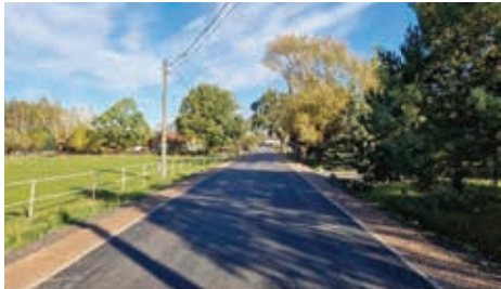
Fot. Przebudowany odcinek ul. Brukowej w miejscowości Olesin (odcinek na północ od autostrady A2)
