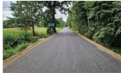
Fot. Przebudowana droga w miejscowości Teresław
