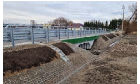
Fot.:Prace drogowe przy moście w ul. Batalionu Parasol w miejscowości Dębe Wielkie
